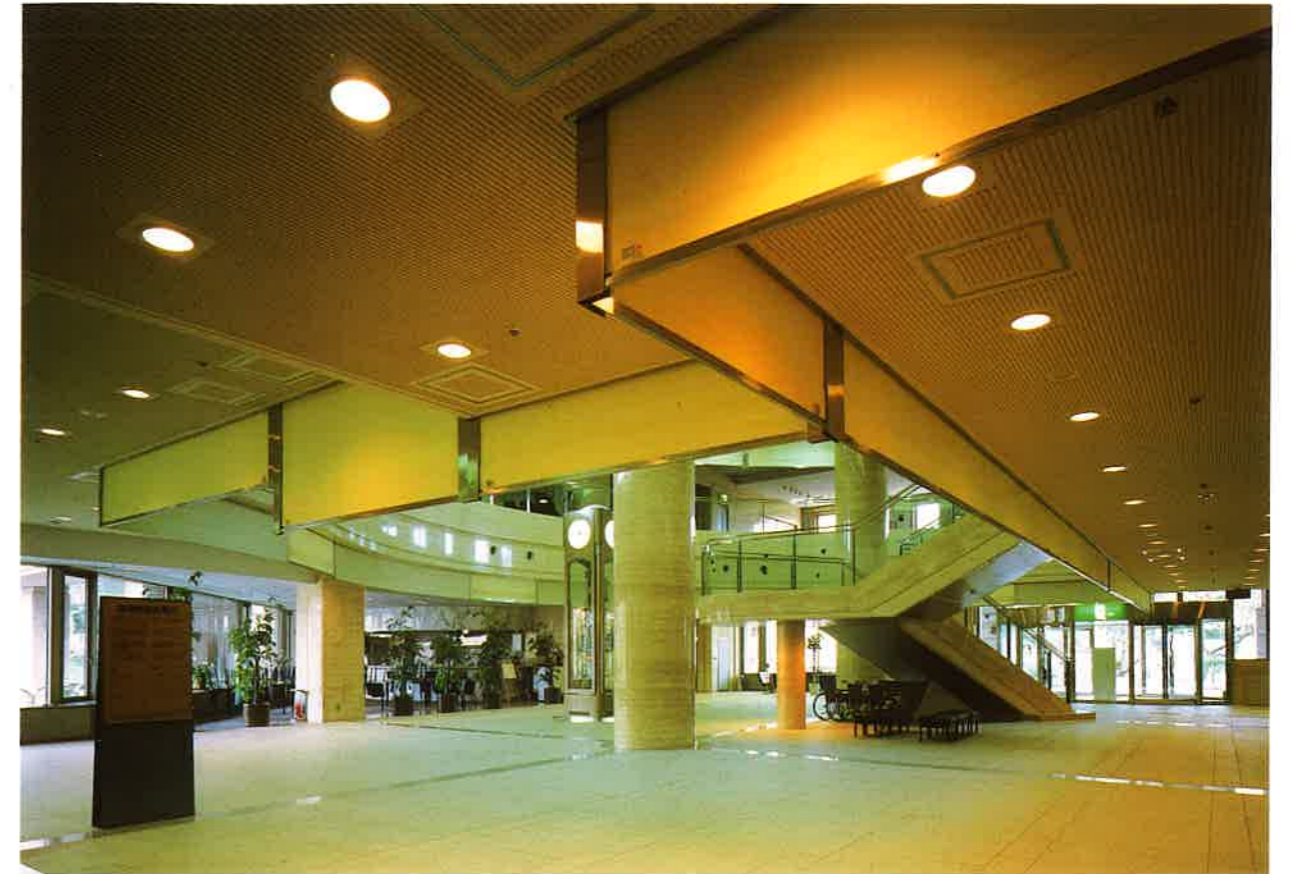
YH-R型、VH型を組合せた吹抜けの防煙垂れ壁
